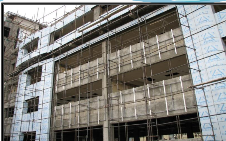
اجرای نمای آلومینیومی بر روی دیوار پانلی
