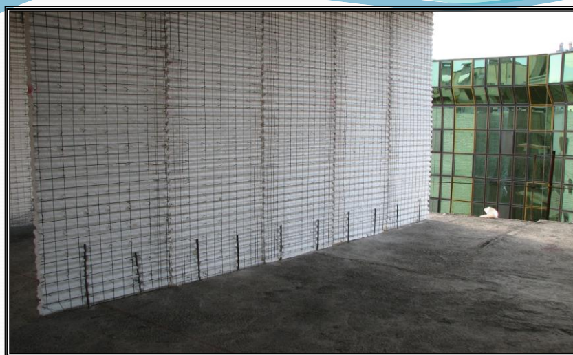
اتصال پانل دیواری به کف
