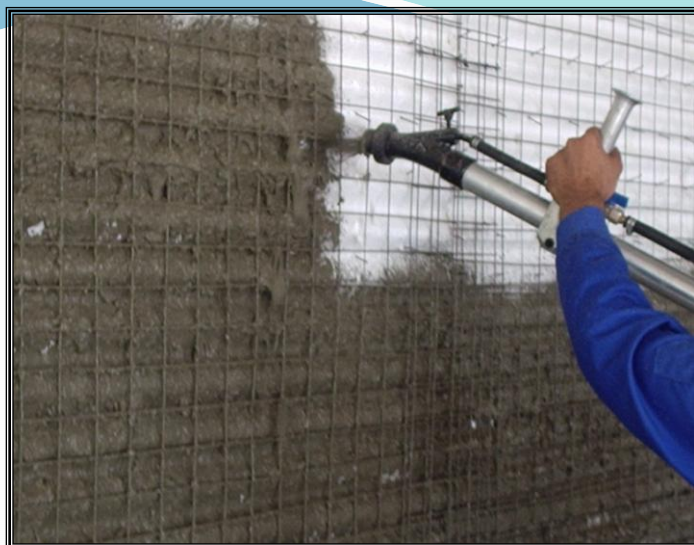
بن پاشی با استفاده از دستگاه بن پاش
