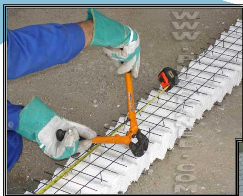
پیش پانل با استفاده از قیچی میگرد بر واره برقی
