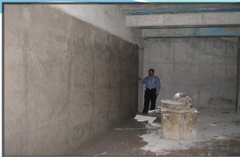
بتن پاشي ديوار داخلي به اتمام رسيده و آماده گچ کاري مي باشد .
