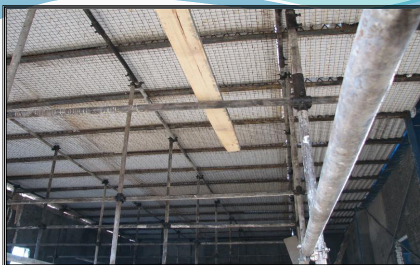
قالب بندی سقف پانلی قبل از بتن ریزی
