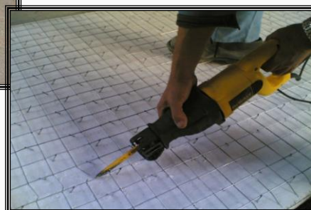
پیش پانل با استفاده از قیچی میگرد بر واره برقی
